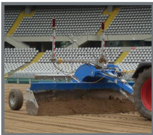
» Stadio delle Alpi — MOBA Dual-Laser-matic utilizado para trabajos de nivelación en el estadio de fútbol del AC Turín (Italia)
